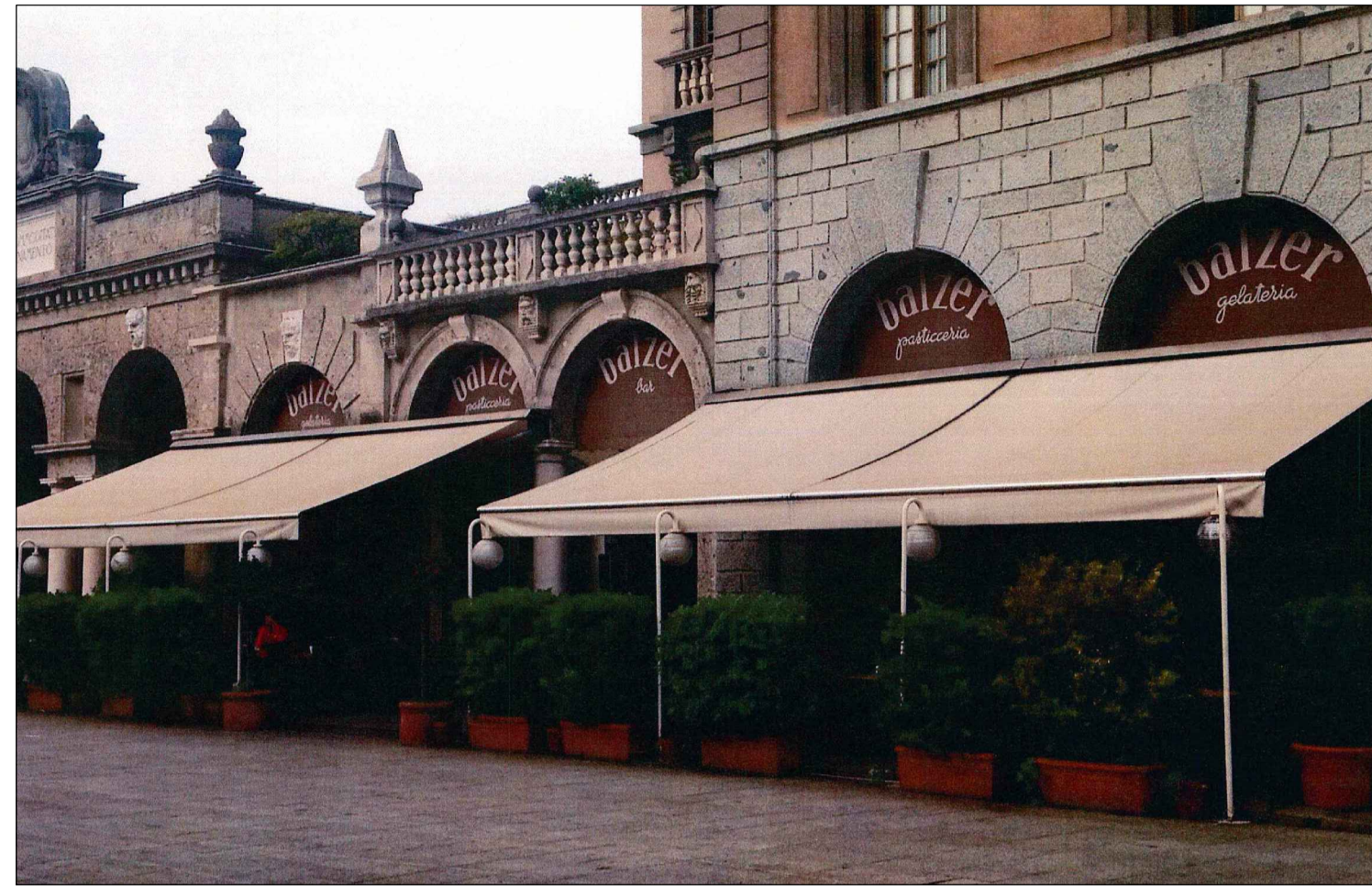
SITUAZIONE PRIMA DELL'INTERVENTO
