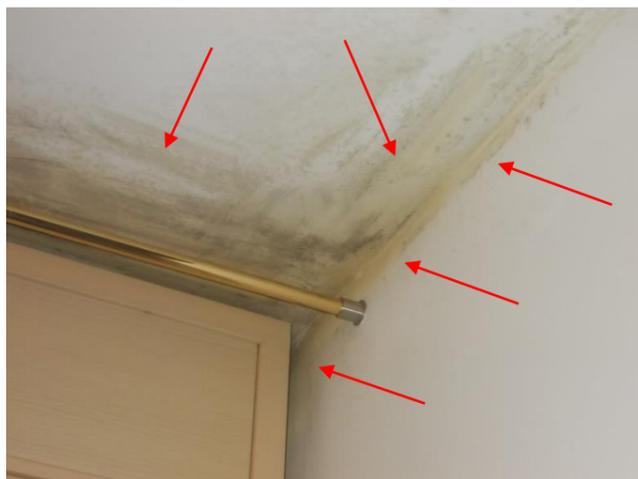
**Figura 5** – Ripresa fotografica fenomeni di formazione di muffe evidenti in corrispondenza del nodo parete verticale-solaio piano sesto
