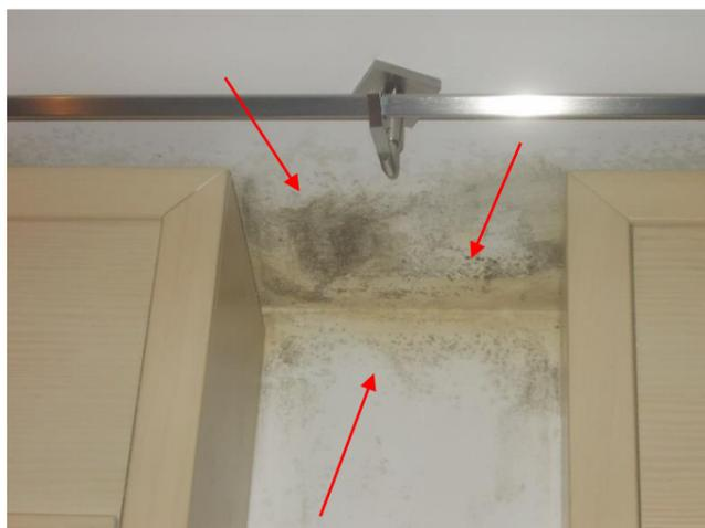
**Figura 1** – Ripresa fotografica fenomeni di formazione di muffe evidenti in corrispondenza del nodo parete verticale-solaio piano sesto
