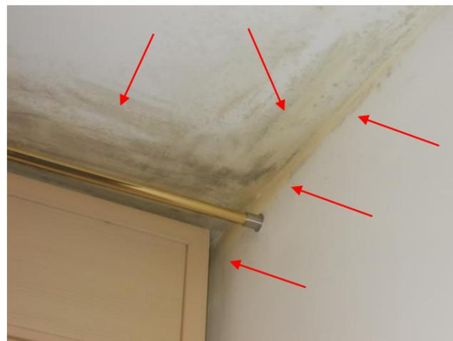
**Figura 6** – Ripresa fotografica fenomeni di formazione di muffe evidenti in corrispondenza del nodo parete verticale-solaio piano sesto
