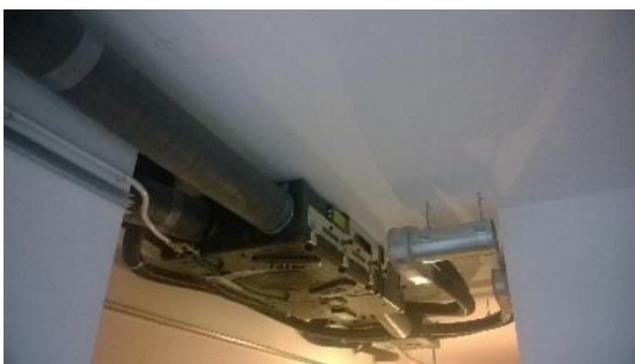
**Figura 17** – Installazione impianto VMC – Installazione macchina a soffitto
