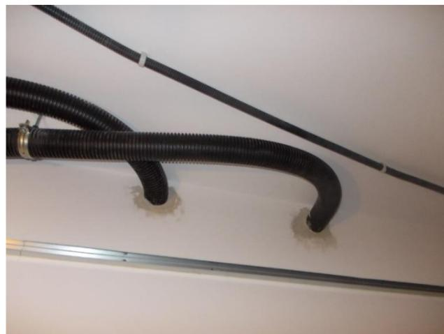
**Figura 15** – Installazione impianto VMC – Canalizzazioni
