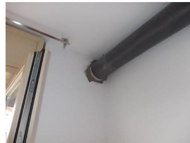
**Figura 16** – Installazione impianto VMC – Canalizzazioni
