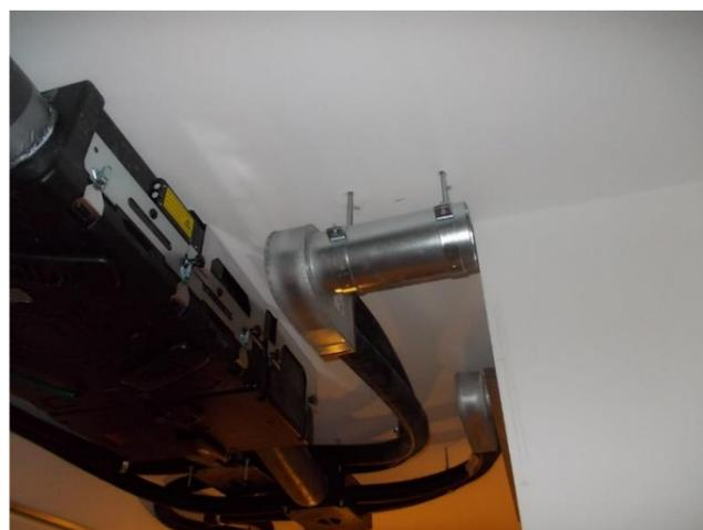
**Figura 18** – Installazione impianto VMC – Installazione macchina a soffitto
