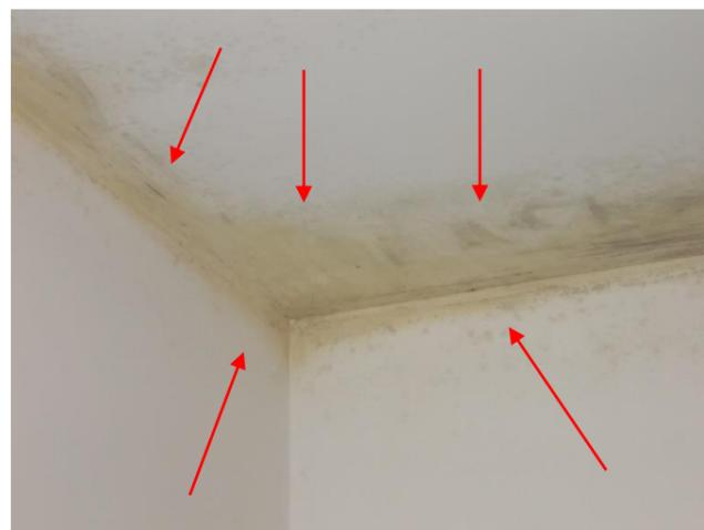
**Figura 2** – Ripresa fotografica fenomeni di formazione di muffe evidenti in corrispondenza del nodo parete verticale-solaio piano sesto
