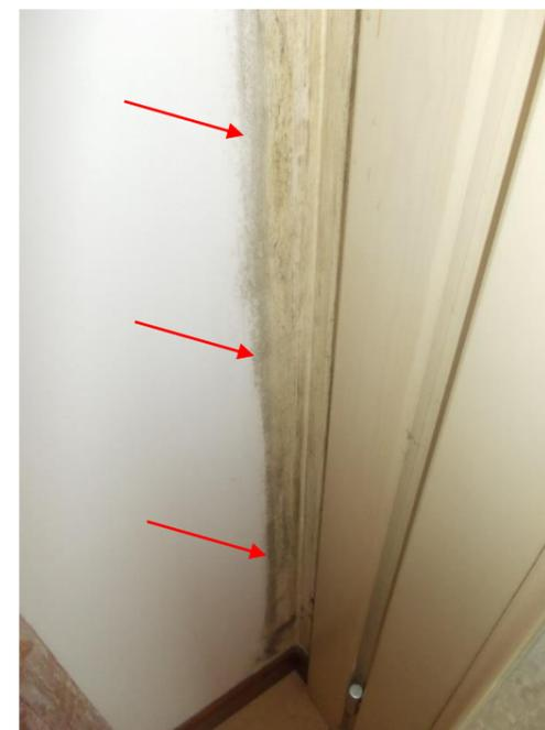
**Figura 3** – Ripresa fotografica fenomeni di formazione di muffe evidenti in corrispondenza del nodo parete-serramento
