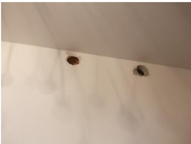
**Figura 14** – Installazione impianto VMC – Forometrie passaggio canalizzazioni
